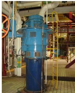
Ilustración 12. Bomba de condensado. Fuente<sup>[12]</sup>
