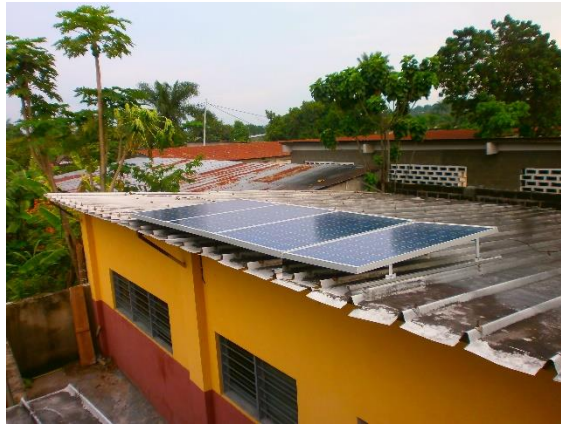
Ilustración 16: Tejado Centro Escolar
