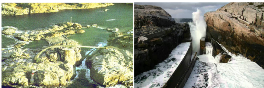
Figura 1.12: Fotografías de la planta de Toftestallen Fuente
