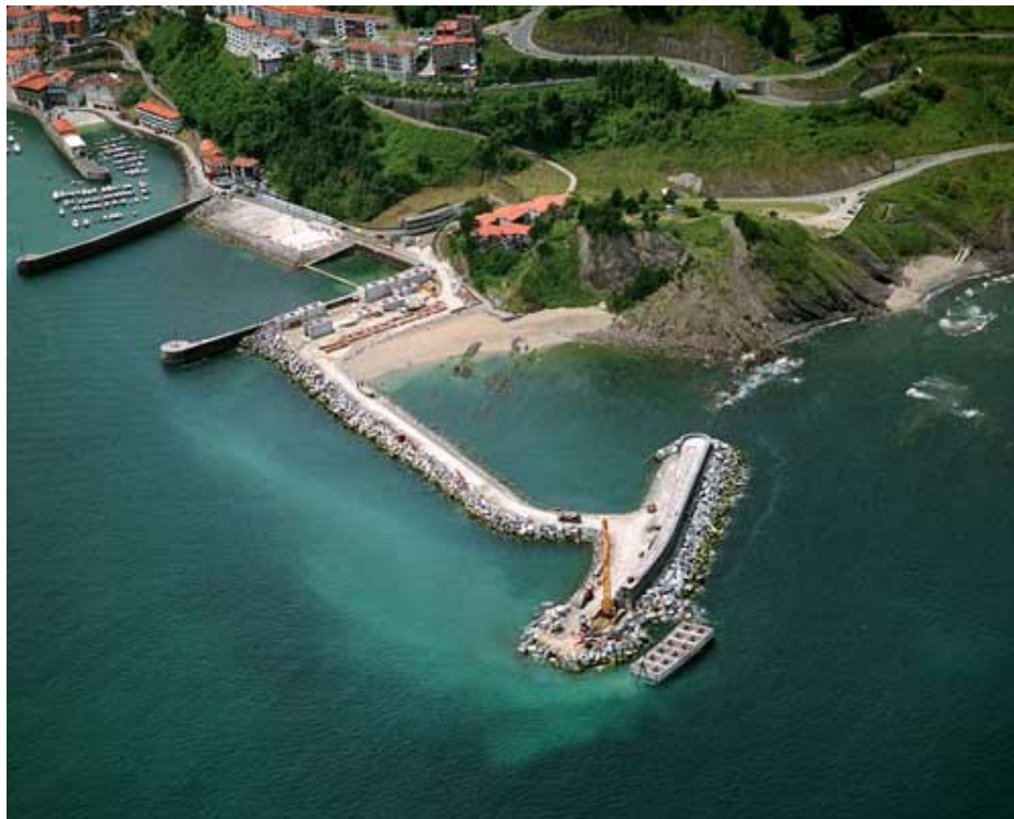
Figura 1.11: Fase de construcción del sistema OWC Fuente
