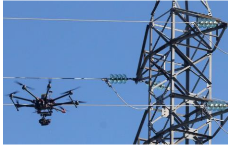
Irudi 16 Linea elektrikoek mantentzea (Iberdrola)
