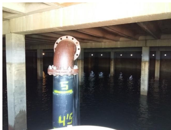
Figura 15: Interior del depósito Agurain II, llegada del agua potabilizada y cotas
