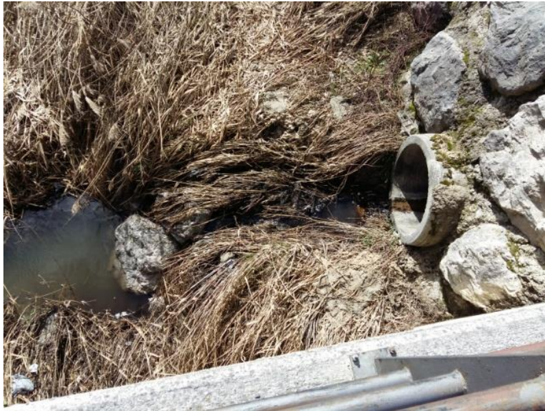
Figura 28: Vertido de pluviales a cauce tipo
