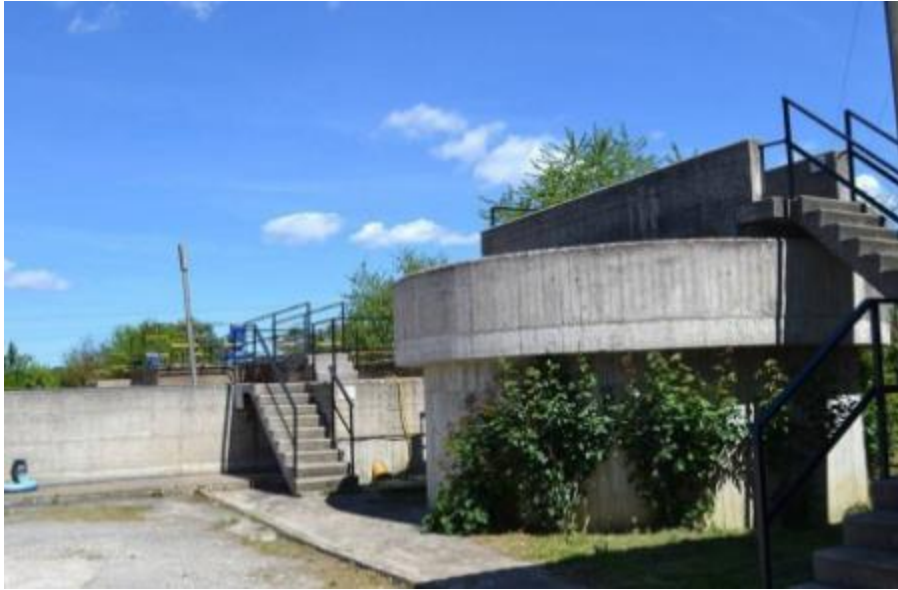
Figura 33: Vista de los tanques biológico y de tratamiento primario (Diario Noticias de Álava)
