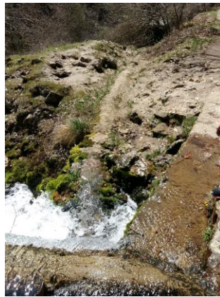
Figura 2: Inicio de la línea de aducción hacia Agurain en Zirauntza
