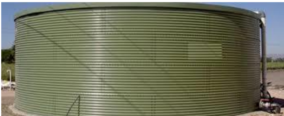
Figura 1: Ejemplo de depósito de emergencias (Google)
