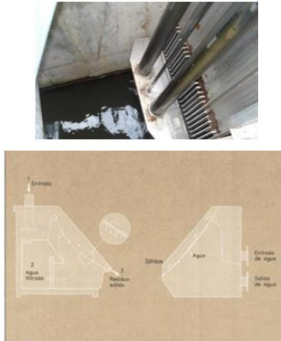
Figura 82: Captación de Logroño y sistema de reja autolimpiante (Rigola Lapeña, 1990)
