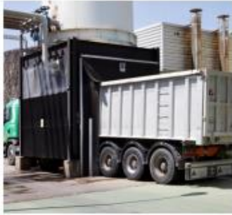
Carga de lodos a camión bañera desde silo.
