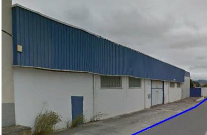
Figura 16: Nave de almacenado. Fuente: Google Earth.
