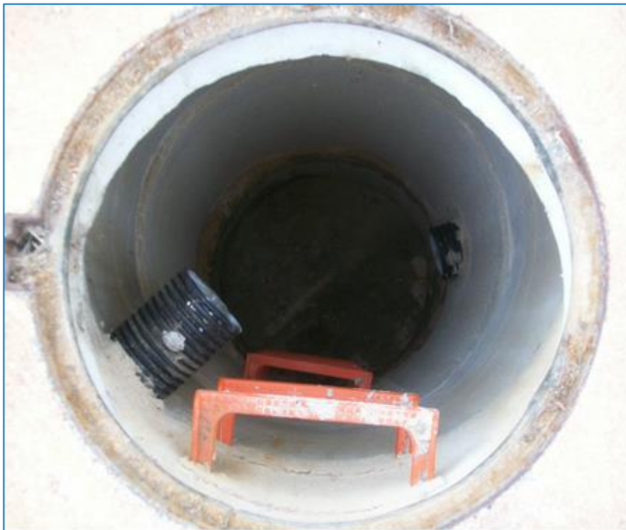
Figura 10: Pozo de registro tipo (Redes DFA)
