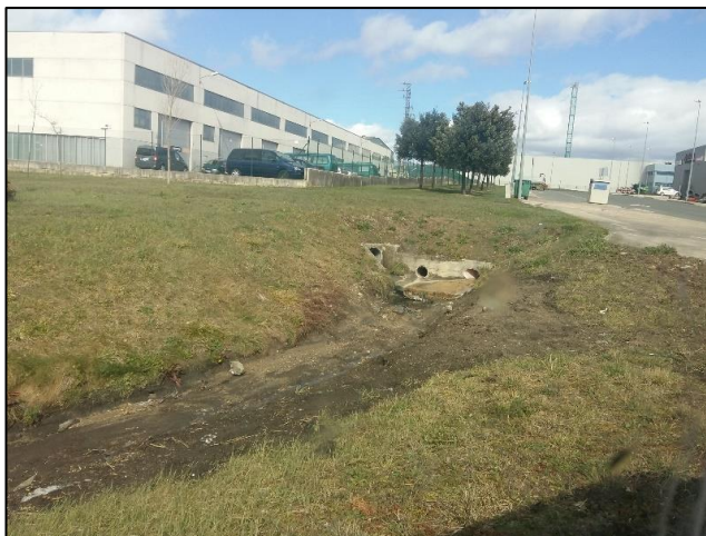
Figura 1: Vertido con arrastre de metales en el PI de Galzar
