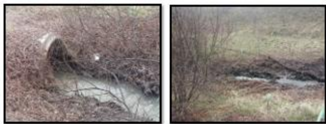
Figura 37: Vertido de la EDAR industrial
