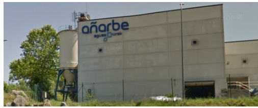
Figura 124: Instalación de Aguas del Añarbe con logotipo (Google Maps)
