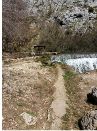
Figura 11: Tubería de aducción de Zirauntza
