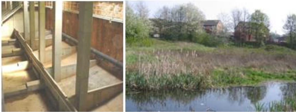
Figura 104: Tanque de tormentas de Burdeos, Izq y estanque de retención en Sheffield, Der (Wikiwater, Consultado en 2018)
