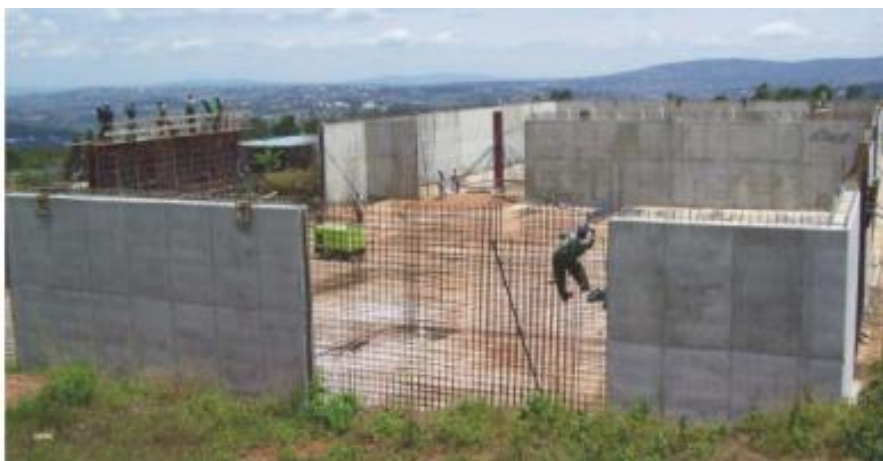
Figura 86: Depósito de hormigón armado, en Kigali, Ruanda (Wikiwater, Consultado en 2018)
