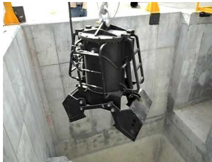
Figura 106: Pozo de gruesos con cuchara bivalva
