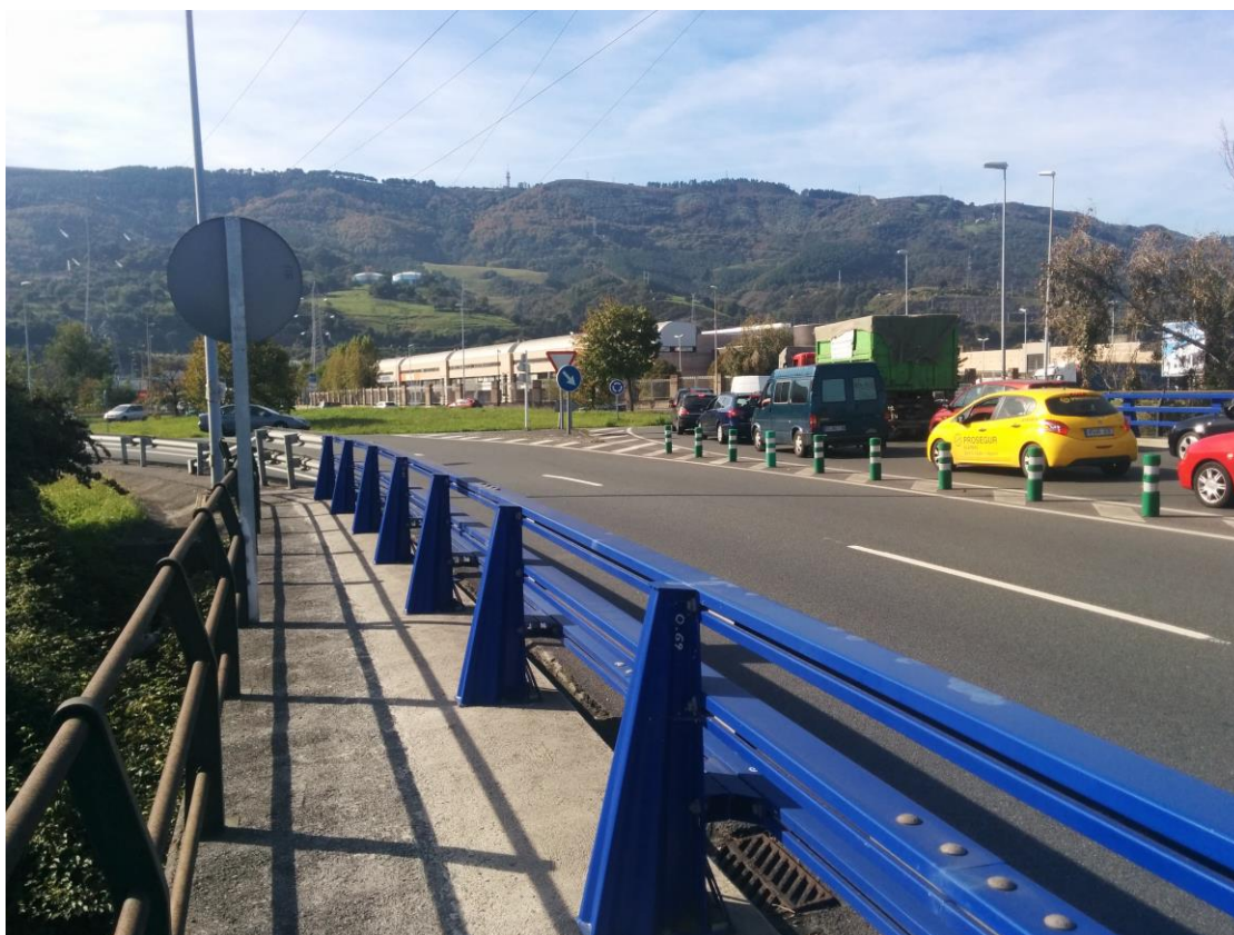
Figura 1.5. – Zona de pasarela
