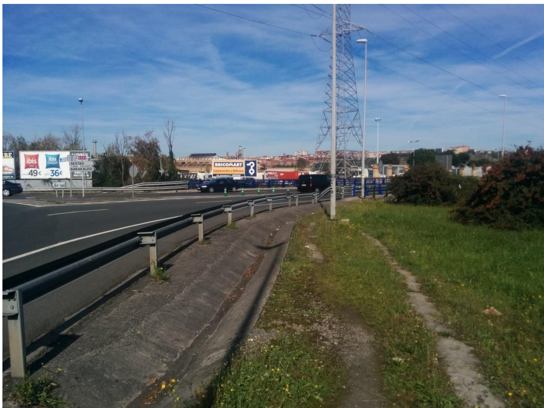
Figura 1.7. – Zona rampas y escalera Este
