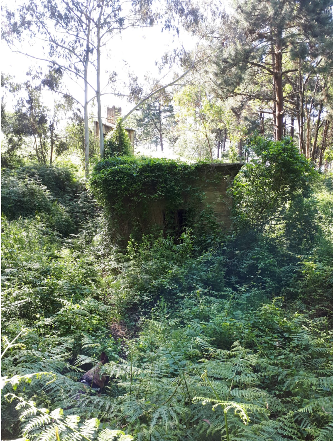
Imagen 2. Estructuras de hormigón a demoler
