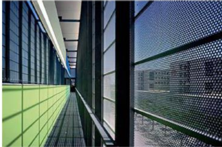
Figura 1: Fachada de doble piel de chapa perforada
