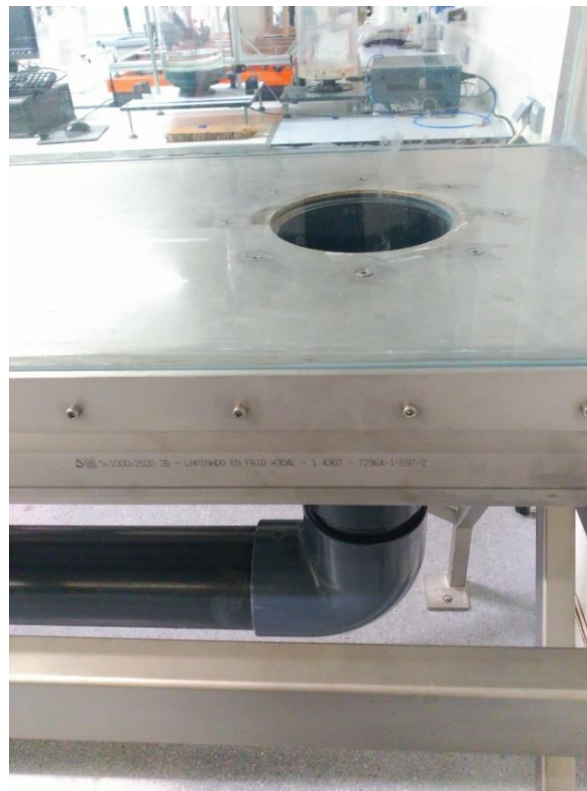
Ilustración 53: Conexión entre el tanque subterráneo y el canal en la zona de generación
