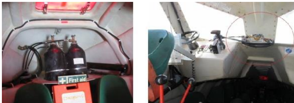
Figura 22: Botellas de aire y regulador del sistema de autoabastecimiento [Figura propia]
