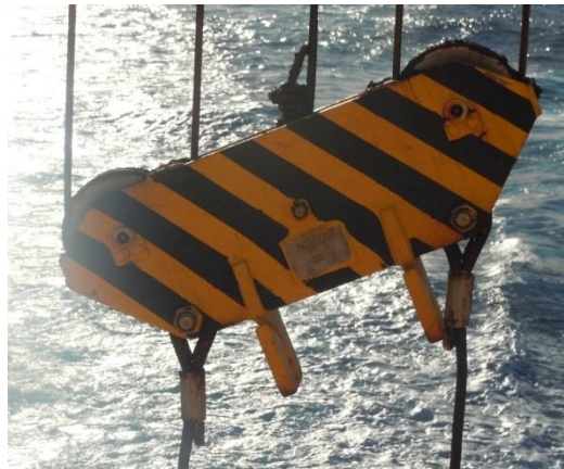
Figura 43: Roldana del gancho del pescante del bote de caída libre bloqueado por falta de lubricación [Figura propia]
