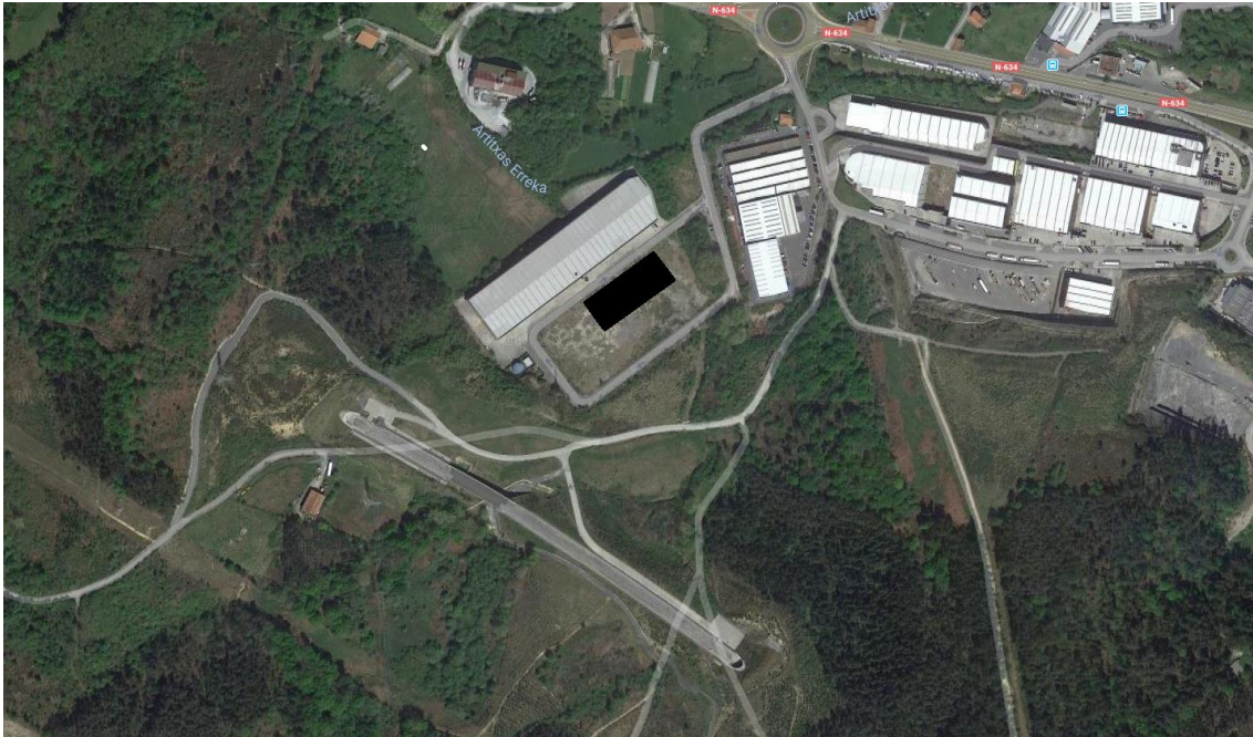
Situación solar en polígono Boroa (Amorebieta-Etxano)
