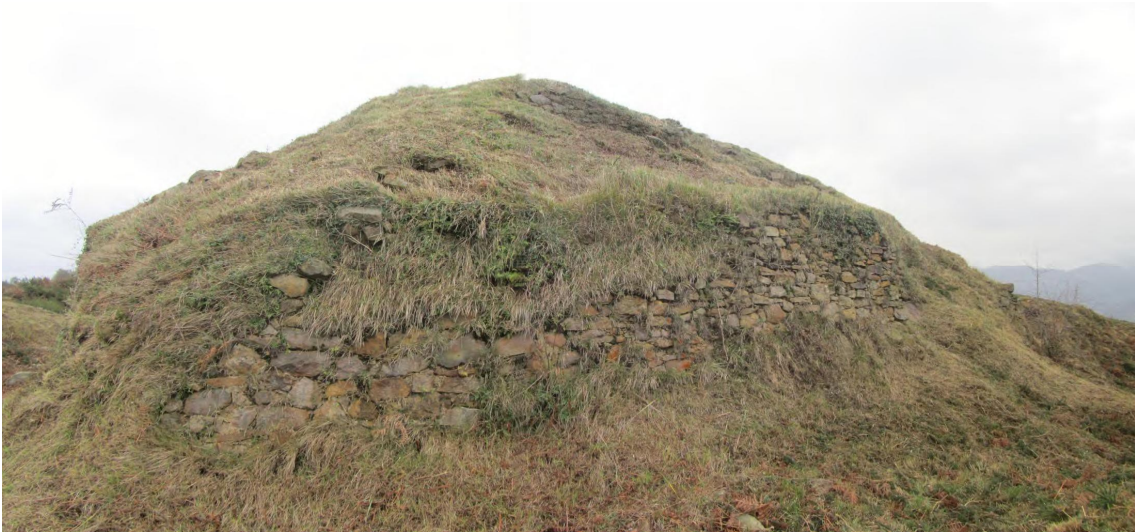
(Figura 47). Torre de San Pablo en 2015. Fuente: TELLERÍA, 2014.
