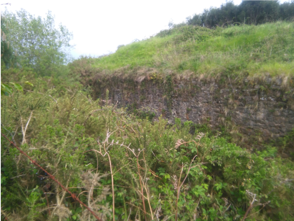
(Figura 11). Lienzo de muro y parte de foso del fuerte del Monte Avril. Fuente: El autor.
