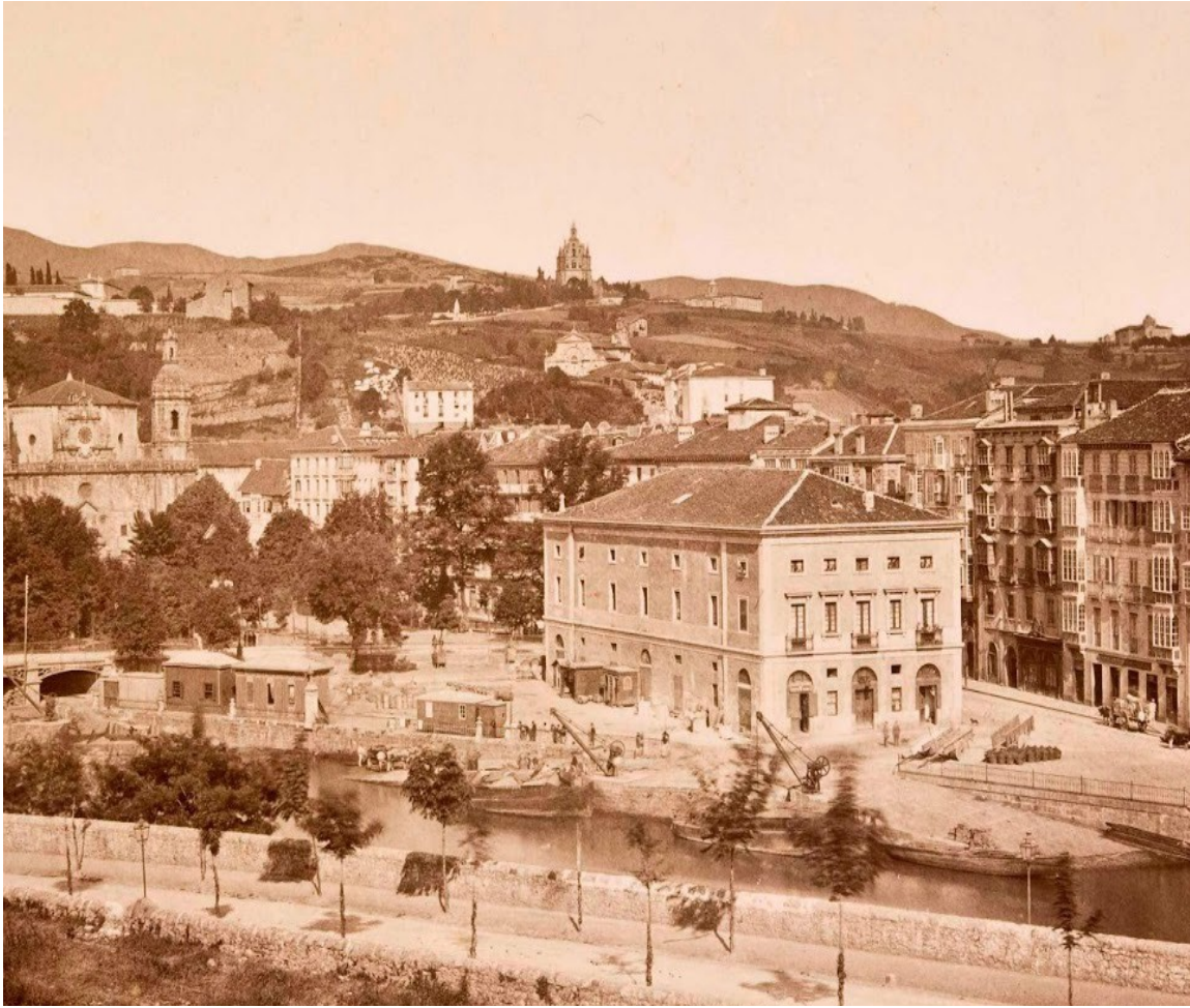
(Figura 62). Teatro convertido en comandancia militar en primer plano y polvorines de madera a su izquierda, junto al puente.
