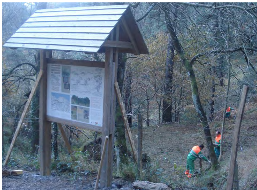
Figura 122: Instalación del panel informativo en Arrastaleku 1 y limpieza y acondicionamiento del yacimiento arqueológico para su visita.
