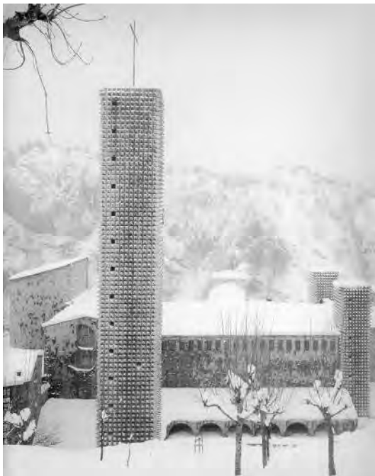
(0.17.) Basílica de Arantzazu. Ábside exterior.
