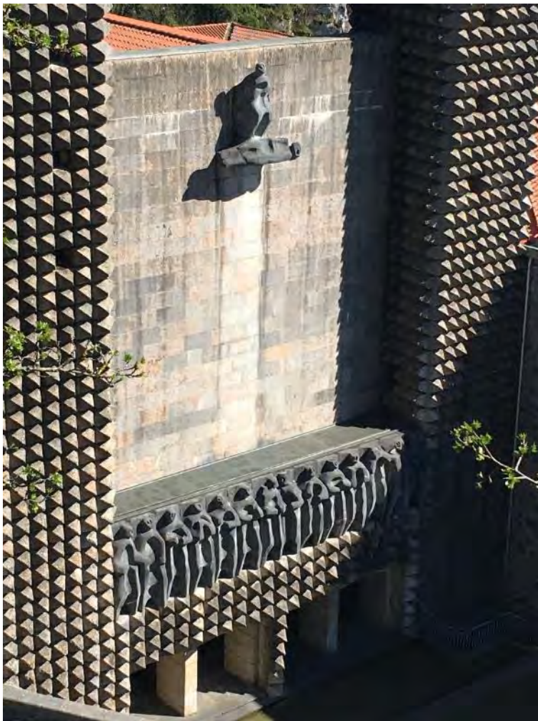
(0.36.) Fotografía de la fachada Basilica de Arantzazu.
