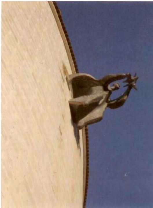
(0.39.) Muro exterior del ábside de la Iglesia de las Arcas reales de Valladolid.
