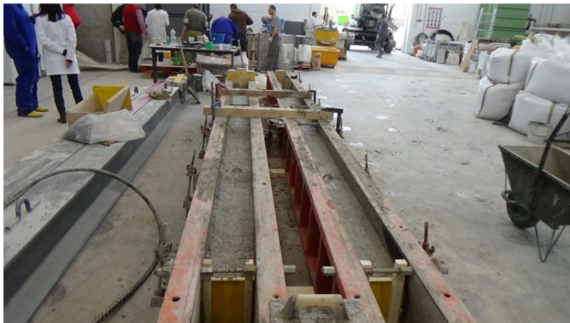
Figura 4.1: Elaboración de vigas con la misma amasada que se ensayará acústicamente.
