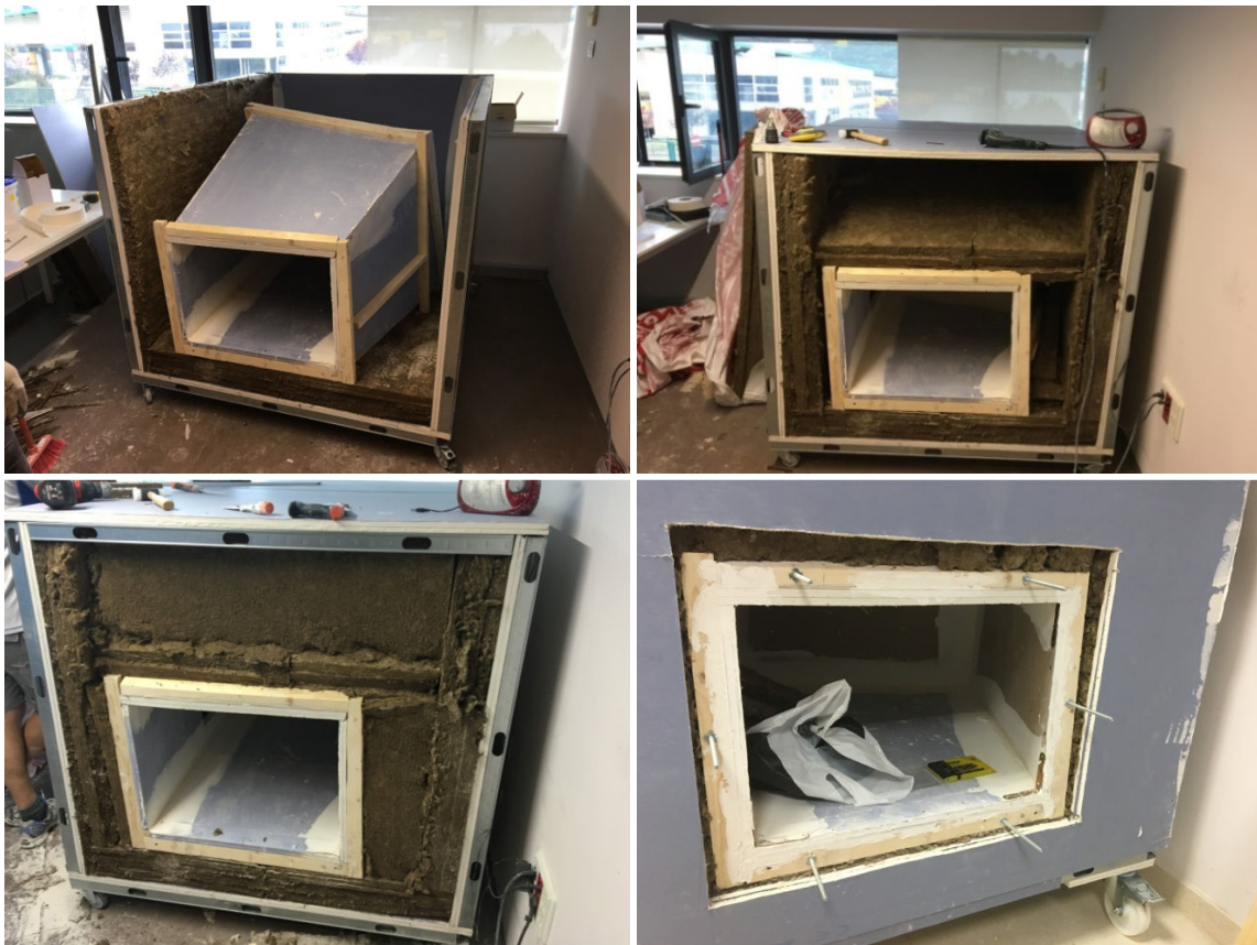
Figura 3.7: Construcción de la cámara emisora (de izquierda a derecha y de arriba a abajo).
