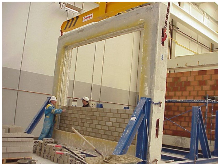
Figura 3.1: Construcción de cerramientos verticales para su ensayo acústico. (fuente: Laboratorio de Control de Calidad de la Edificación del Gobierno Vasco)
