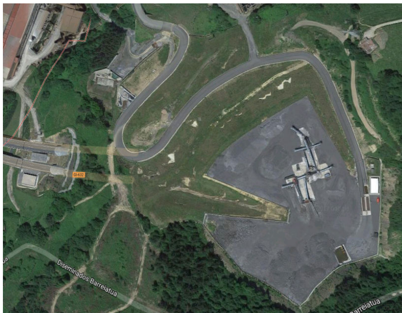
Figura 2.4: Vertedero de escorias en Zumarraga (Gipuzkoa). Foto: Google maps
