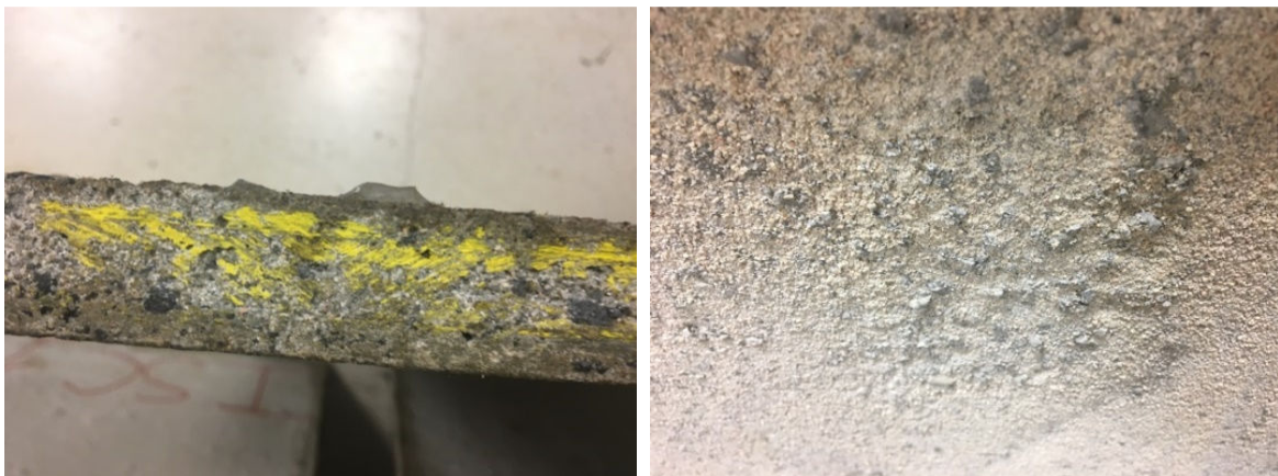
Figura 4.15: muestra I-SC-S. En la fotografía de la izquierda se aprecia la lechada concentrada en la parte inferior.
