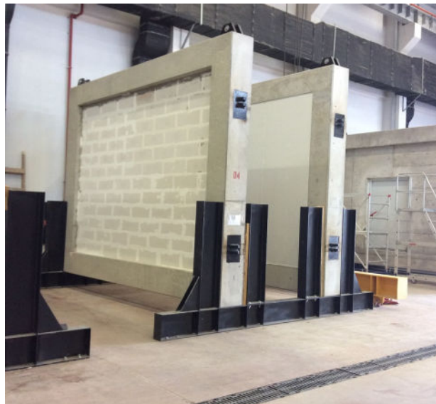
Figura 2.18: Muestras para acústica construidas en un marco de hormigón, pendientes ensayo en Lab. Control de Calidad de la Edificación de Gobierno Vasco. Área de Acústica (fuente: Tecnalia)
