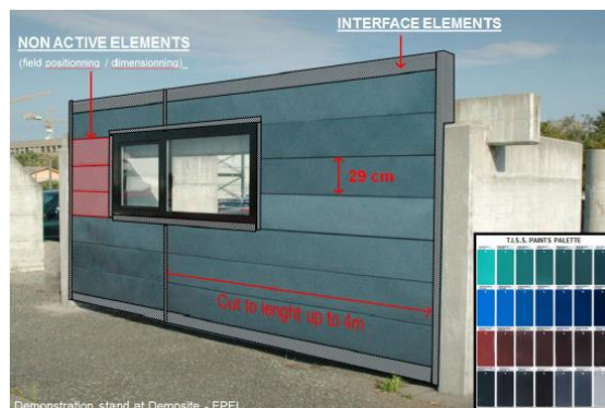
Ilustración 26 Aplicación de colectores SOLABS (52)
