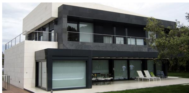
Ilustración 23 Fachada ventilada en piedra (47)
