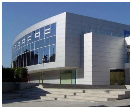
Ilustración 25 Revestimiento aluminio composite (50)
