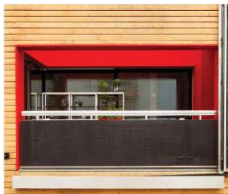
Ilustración 30 Barandilla termodinámica del proyecto RhOME (35)
