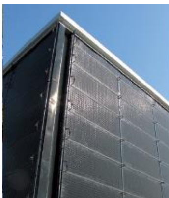
Ilustración 27 Colectores de LA TOITURE SOLAIRE (53)
