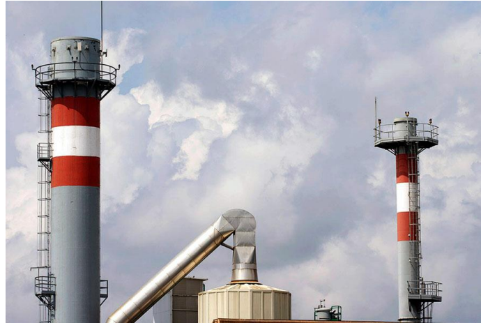
Ilustración 39. Chimeneas con plataforma para el análisis y control de emisiones
