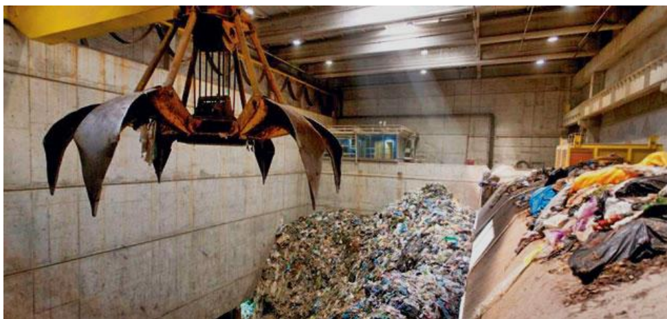
Ilustración 30. Foso de almacenamiento de residuos
