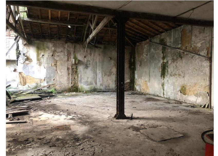
En estas foto se aprecia que los pilares perimetrales, originalmente eran de madera pero fueron sustituidos por pilares metálicos, es una solución rápida que dieron hace un par de años cuando vieron que la casa se podría derrumbar completamente.
