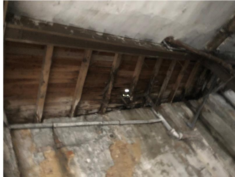
La cubierta a tres aguas del local izquierdo, propuesta en el proyecto, se ha construido a cuatro aguas y hoy se encuentra parcialmente derrumbada y los escombros siguen en el interior del local.
