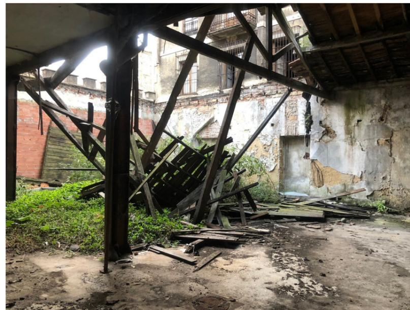
En cuanto al local del lado derecho, la cubierta a un agua aún se mantiene aunque tiene agujeros en varios sitios y parte de la estructura de madera está quemada después de un incendio que tuvo lugar hace un par de años.
