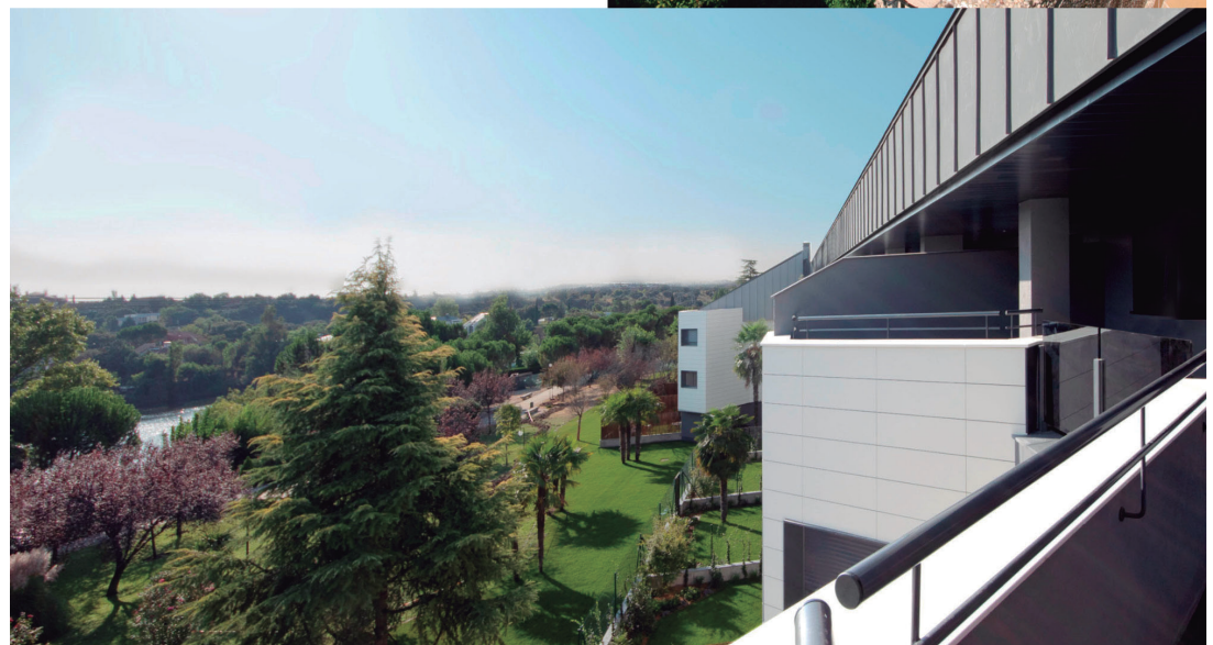
Figura 4. Sección constructiva general del edificio. Imagen anterior de la fachada y su encuentro con la barandilla. Imagen final de la rehabilitación de la fachada.
