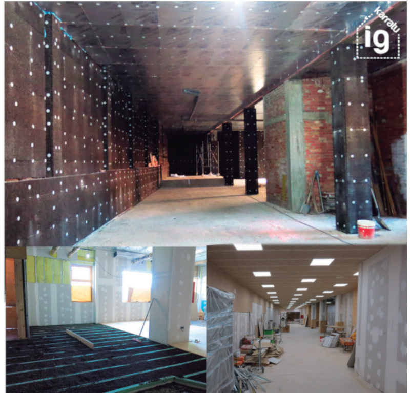
Figura 4. Una de las secciones constructivas y el montaje de aislamientos térmicos.
