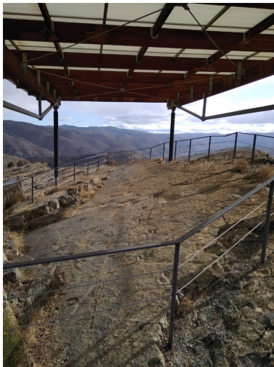
Fig. 1.- Vista de la zona cubierta del yacimiento de Peñaportillo.
