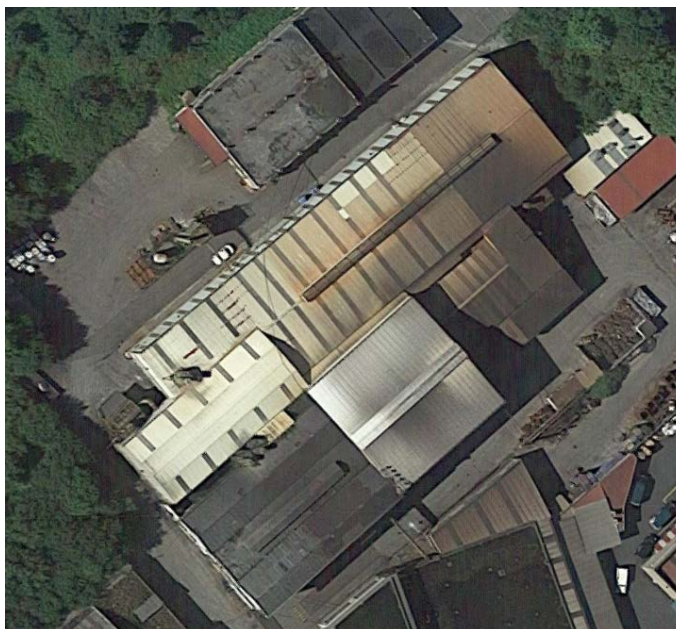
Ilustración 4.33 - Cubierta de una fundición en Santa Apolonia. Fuente: Google Earth
