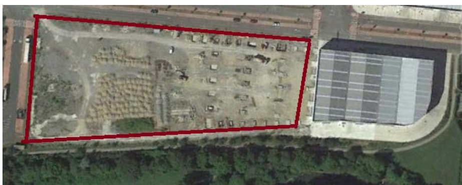
Ilustración 4.23 - Superficie sin edificar parcela 3. (Fuente: Google Earth)
