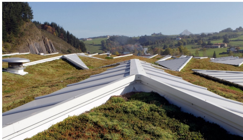
Ilustración 4.11 - Cubierta verde en Idiazabal, Gipuzkoa. (Fuente: Interempresas)
