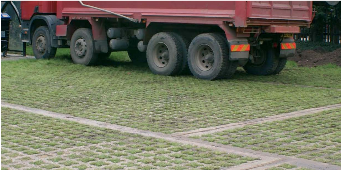
Ilustración 4.16 - Pavimentos de hierba y hormigón. (Fuente: Grasscrete)
