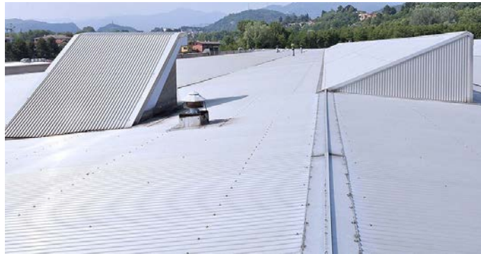
Ilustración 4.7 - Cubierta con aislamiento termo-reflectante. (Fuente: Reveton)
