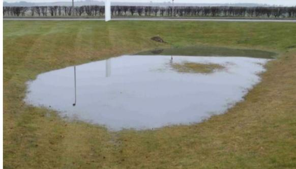
**Ilustración 5-14. Depósito de infiltración.**
