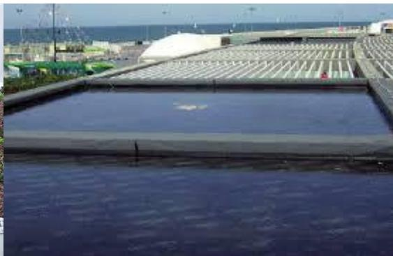
**Ilustración 5-9. Cubierta inundada.**
