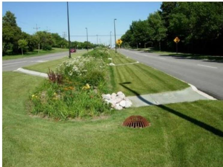
**Ilustración 5-11. Zanja filtrante.**
