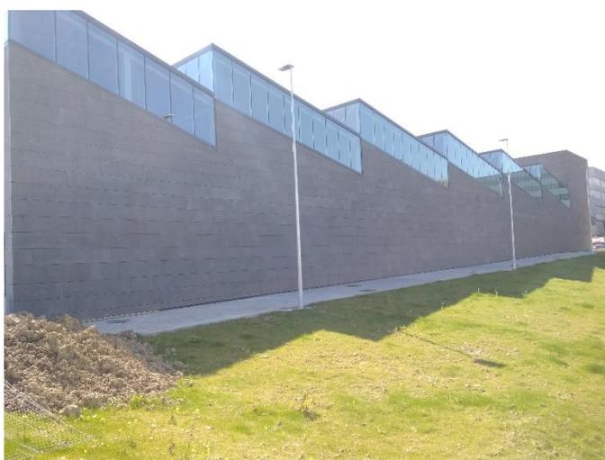
Ilustración 6-8. Montorreta, cubierta de diente de sierra y fachada ventilada.
