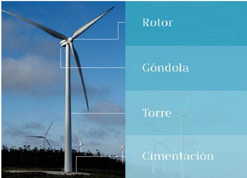
Figura 1 Partes de un aerogenerador
