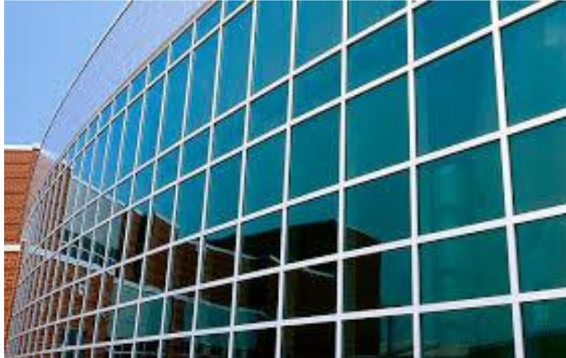
*Figura 5.10: Muro cortina con perfiles metálicos. [23]*
