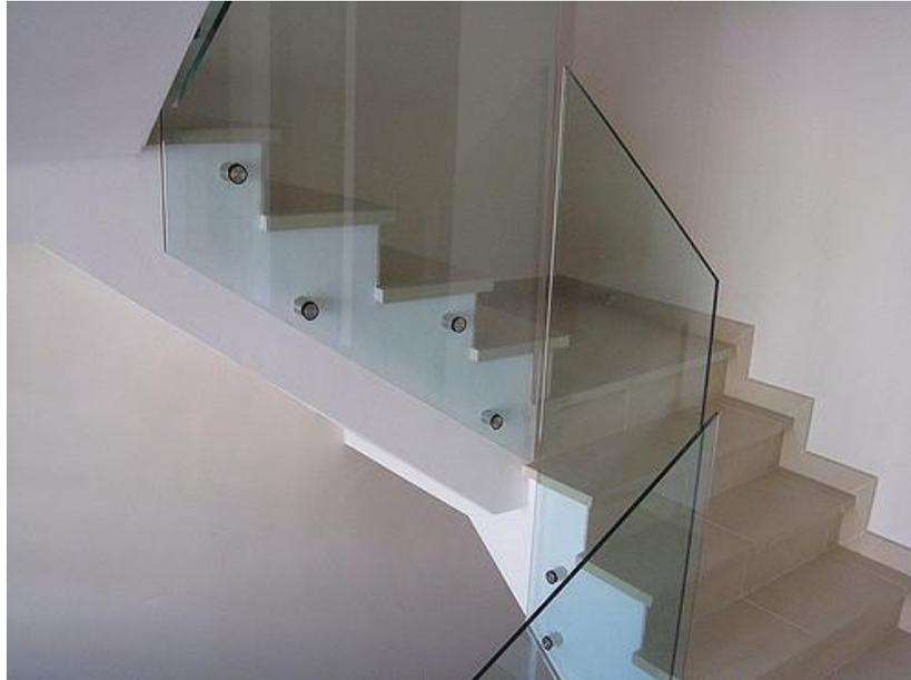
**Figura 7.7:** Sujeciones de una barandilla de vidrio. [14]
