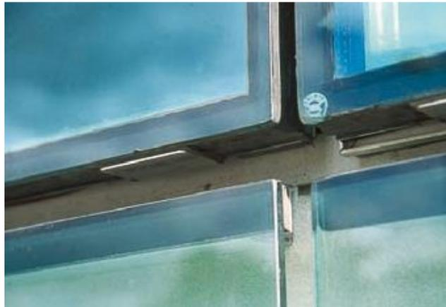
**Figura 5.11:** Acristalamiento estructural exterior. [1]
