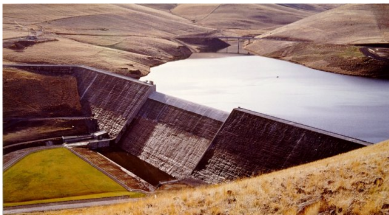
Irudia 5.1: Grabitatezko Willow Creek presa, Heppner, Oregon, EEBB. Iturria: damengineer.com
