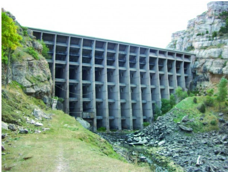
Irudia 5.3: Ambursen egiturako La Prele presa, Douglas, Wyoming, EEBB. Iturria: trib.com
