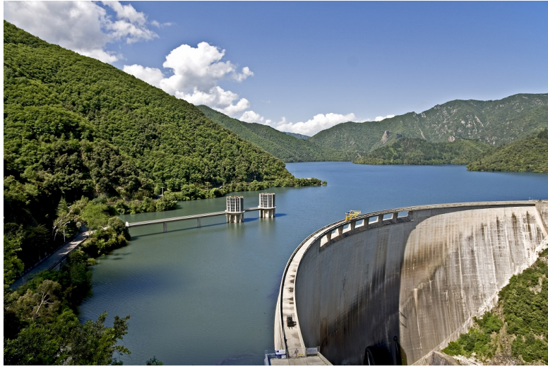
Irudia 5.5: Ganga itxurako Susquedako presa, Susqueda, Katalunia, Espaina. Iturria: Susquedako Udala
