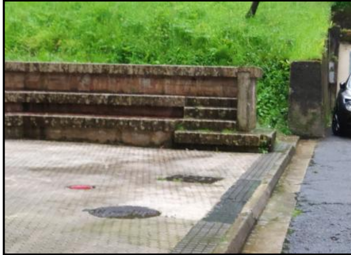
Figura 5. Muro y escaleras a demoler en el inicio del camino peatonal.
