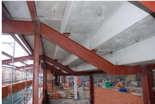
Imagen 33. Estructura de gradas prefabricadas.
