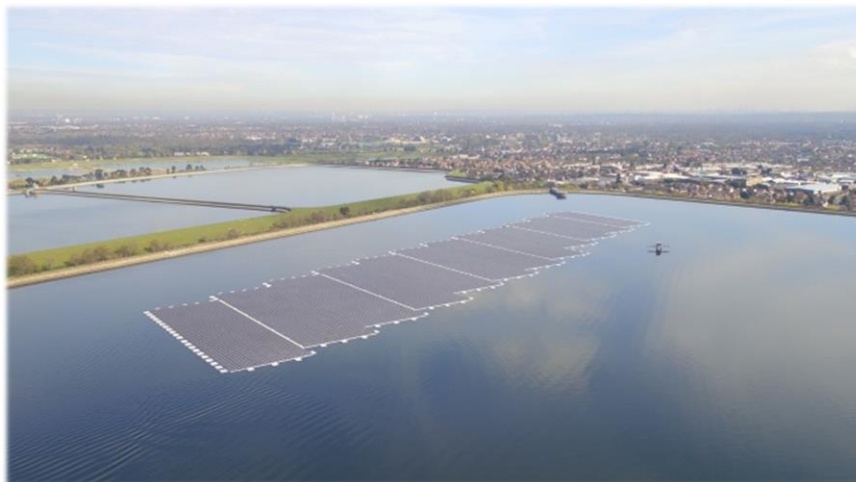
Figura 15: Planta fotovoltaica de la reserva Queen Elizabeth II (Reino Unido) de 6.3 MW. Fuente: paperpower.com
