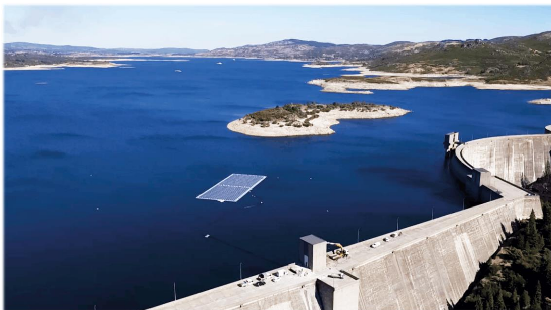
Figura 24: Planta fotovoltaica híbrida de Montalegre (Portugal) de 218 KWP. Fuente: Ciel et Terre
