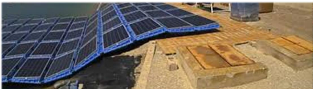
Figura 75: Ejemplo de lanzamiento de una instalación fotovoltaica flotante. Fuente: Isofloating
