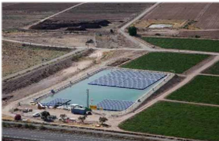
Figura 17: Planta fotovoltaica de Huerto Chico (Murcia). Fuente: Ferrovial
