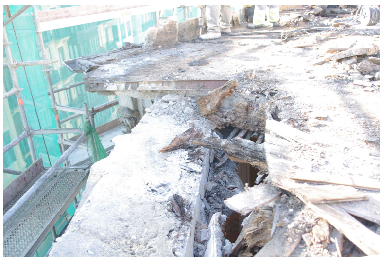
Figura 1. 22.- Fenómeno patológico de podrición de las cabezas de solivos de madera.
