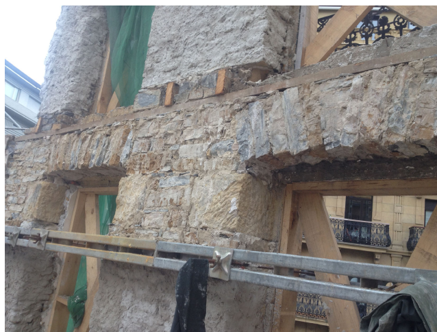
2. 20. Irudia- Hareharrizko eta kareharrizko horma baten barnealdeko xehetasun konstruktiboa eta kanpoko eta barruko geruzak trabatzeko zeharkatzen duen hareharrizko harlandua.
