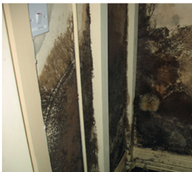
Figura 1. 21.-Caso extremo de crecimiento de moho en la parte interior de un muro [43].
