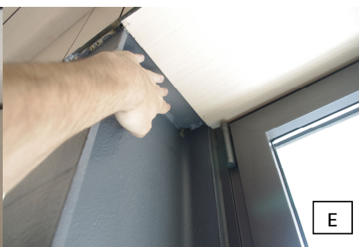
2. 18. Irudia- C eraikinaren estalkiaren ezaugarriak: A) Xehetasun-konstruktiboa B) Sabaiaren akabera C) Estalkiaren akabera D/E) Aire-ihesen detekzioa.
