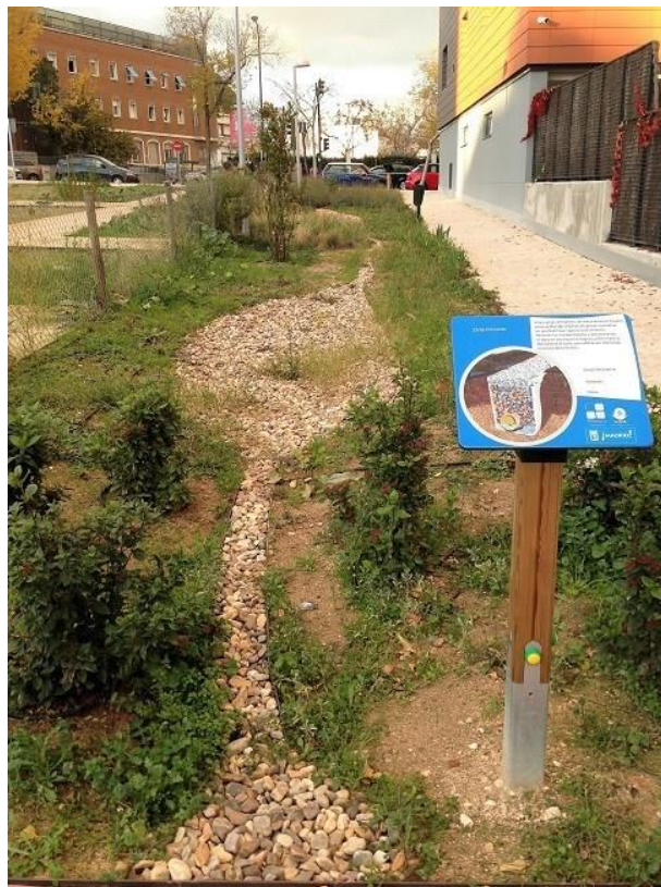
24. irudia: infiltrazio zangen adibidea. Iturria: Madrileko Udala.
