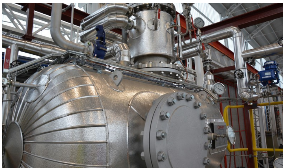
Ilustración 27. DESGASIFICADOR
