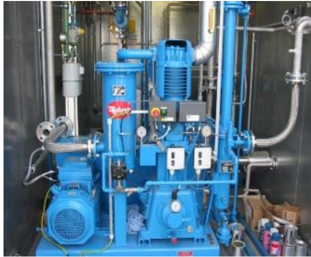
Figura 58. Compresor de pistón Josef Mehrer GmbH & Co KG, modelo TEL 30/S3-15-F utilizado para la compresión de biometano [182].
