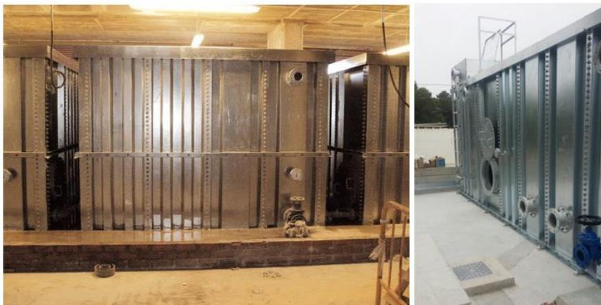
**Figura 54: Tanque de almacenamiento rectangular. [41]**
