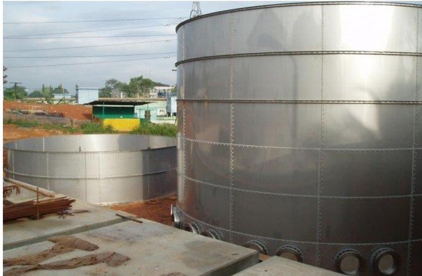
Figura 41: Tanque de almacenamiento de agua regenerada. [41]
