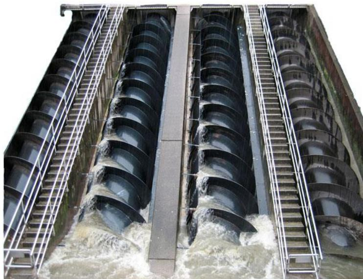
Figura 31: Bomba de tornillo de Arquímedes. [37]
