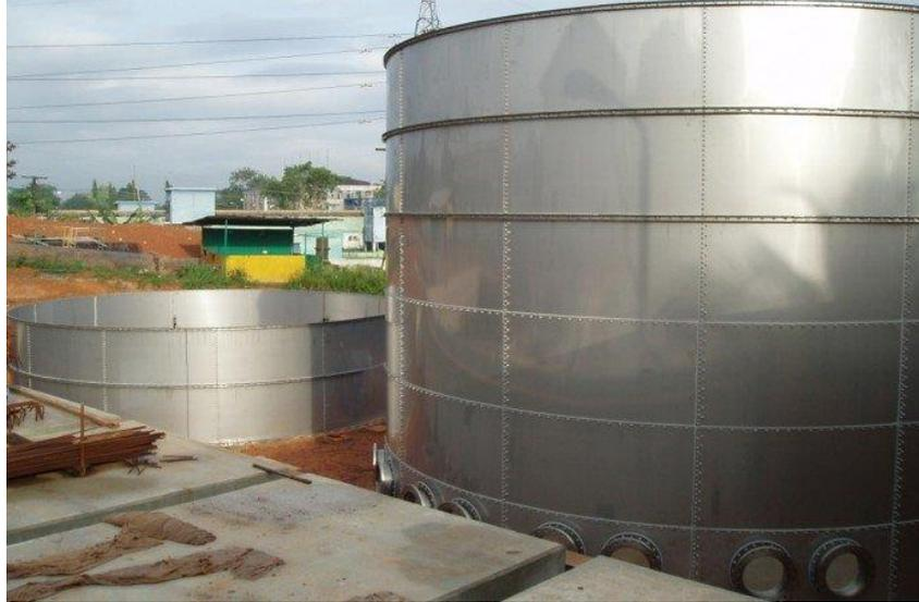
**Figura 53: Tanque de almacenamiento cilíndrico. [41]**
