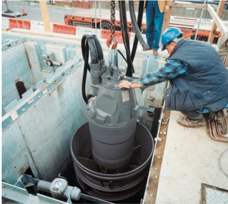
**Figura 32: Puesta en obra de Bombas sumergibles de Hélice. [38]**
