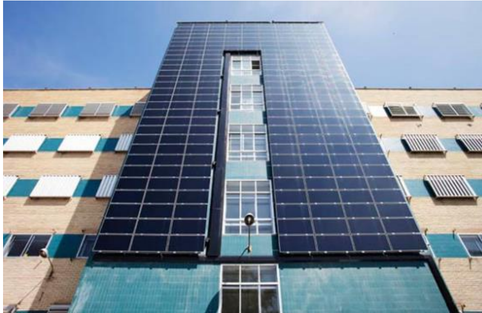
Imagen 10: Ejemplo de edificio con integración fotovoltaica
