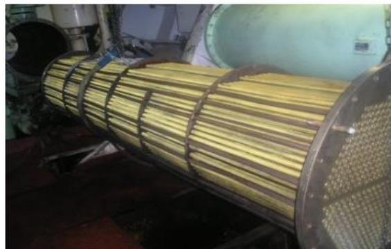
**Ilustración 21. Condensador por fuera y por dentro**
