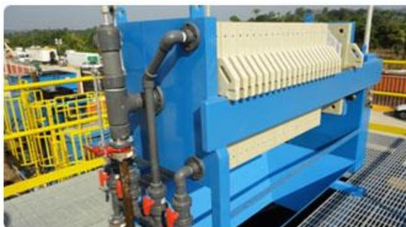
**Ilustración 7. Dispositivo de deshidratación mecánica**
