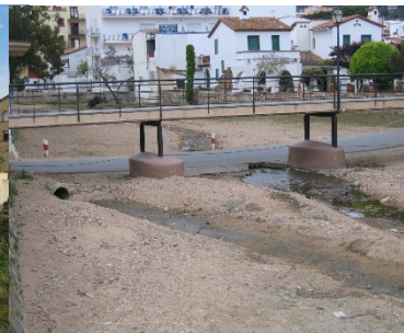
Torrent de Montllort, Tossa de Mar, Girona
