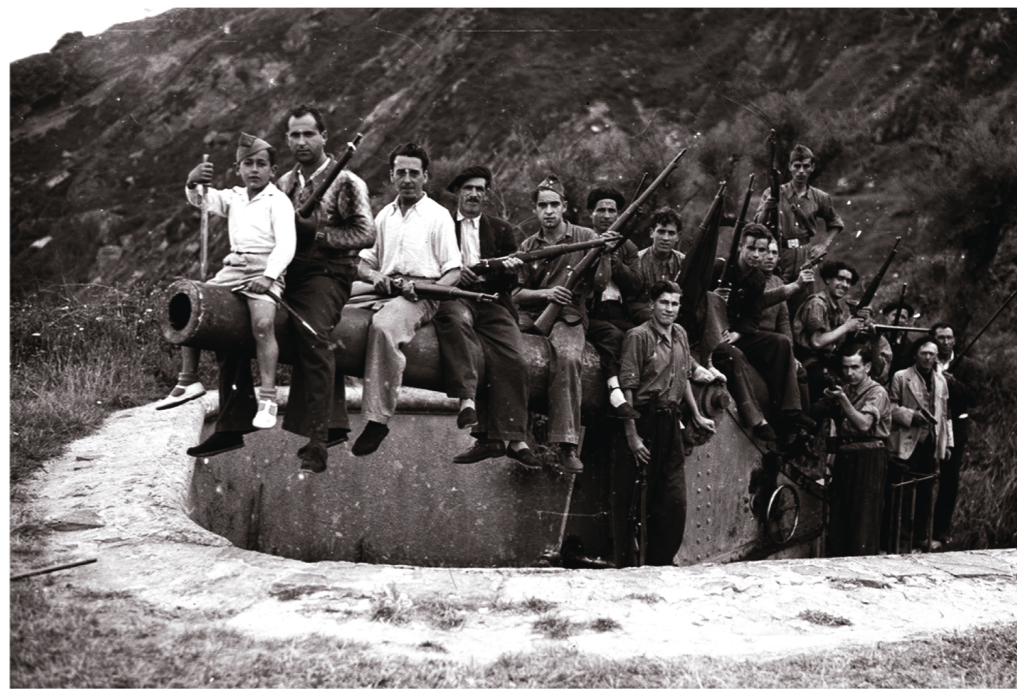
Batería de la diputación de Guipuzcoa. La fotografía es posterior a 1909, pues se puede observar sobre el acceso una lápida en la que consta ya la nueva denominación
