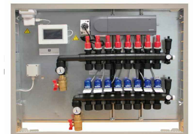
Zoru eta pareta erradiatzaileen kolektorea Konfort Port UPONOR
