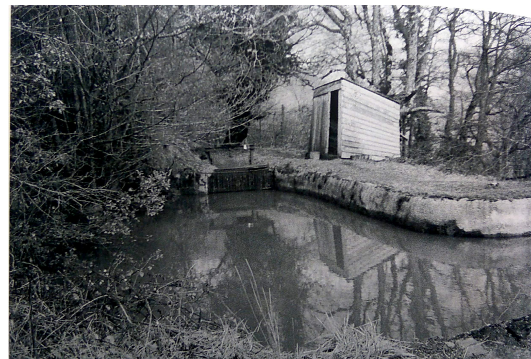
Ur bideak emaria kontrolatzen zuten urtegi batzuetan amaitzen ziren, fabrikaren makinaria aktibatzen zuten turbinak mugitu ahal izateko. 1
