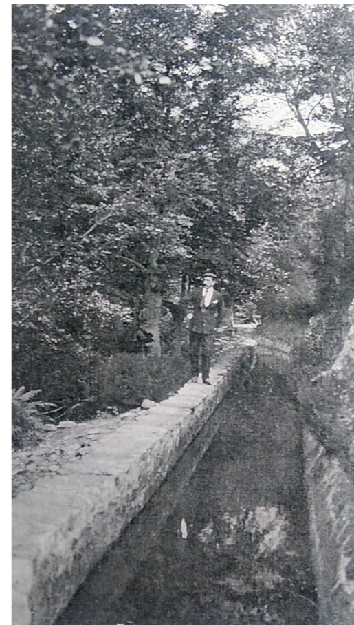
Ibaiaren presaren ura ubide batzuen bidez zentral hidroelektrikora bideratzen zen, hala nola fabrikaren eta burdinolaren instalakuntzetara. 1
