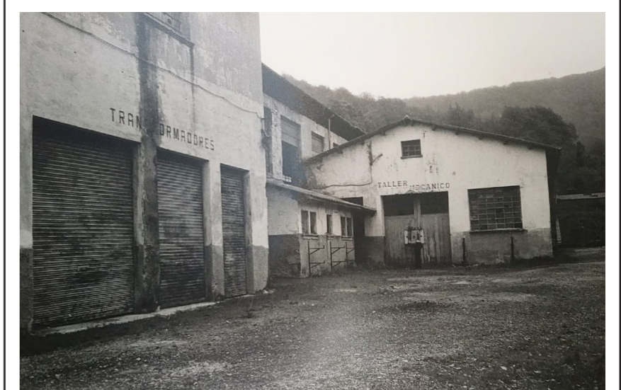
6 Transformatzaileak, komunak eta tailer mekanikoak. 5
