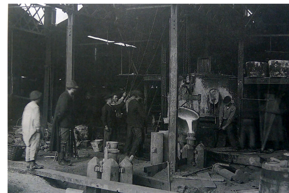
Kanporatutako produktua lingotera batzuetan ezartzen zen, bere gogortasun handiarekin erremintak sortzeko erabiltzen zen (barrenak eta minen pistoletak) 1
