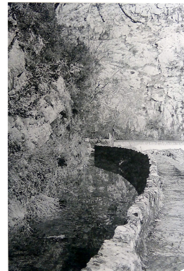
Ibaiaren presaren ura ubide batzuen bidez zentral hidroelektrikora bideratzen zen, hala nola fabrikaren eta burdinolaren instalakuntzetara. 1
