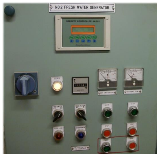
Ilustración 32. Panel de control del FWG. Fuente: Propia.
