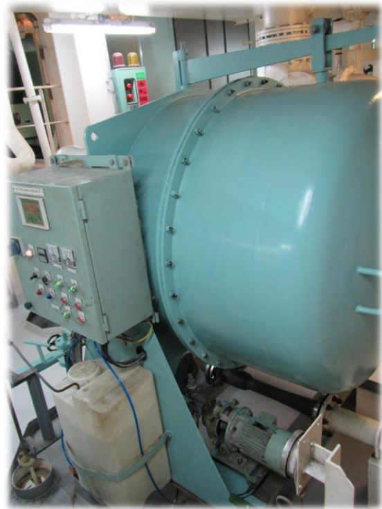
Ilustración 28. Vista frontal, lateral y trasera de un FWG. Fuente: Propia.
