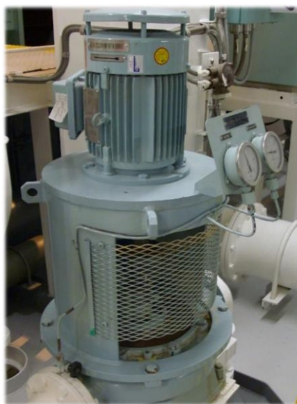
Ilustración 31. Fresh water jacket pump. Fuente: Propia.
