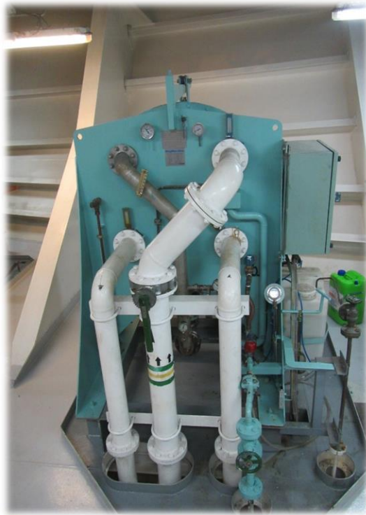
Ilustración 28. Vista frontal, lateral y trasera de un FWG. Fuente: Propia.
