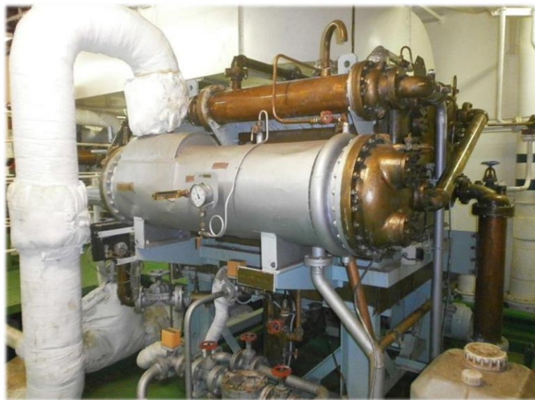
Ilustración 36. FWG de tipo flash. Fuente: LNG Catalunya Spirit.
