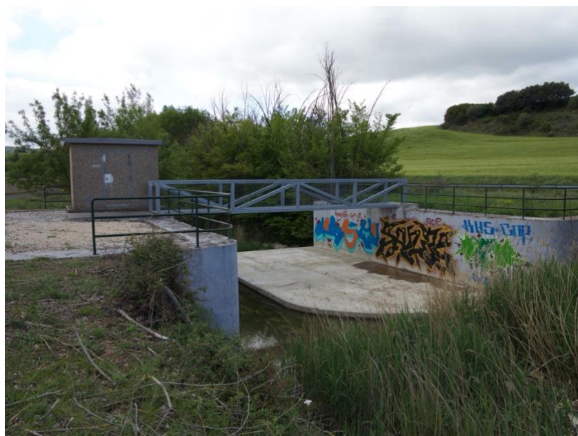
Figura 15.- Estación de aforo y encauzamiento con escolleras laterales en el río Salado.
