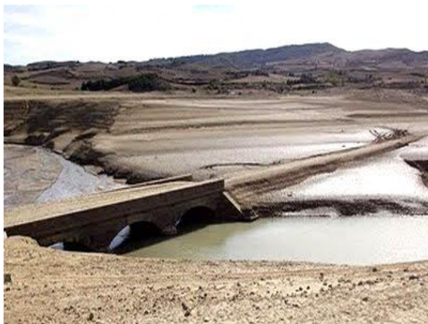
Figura 27. Puente románico bajo el embalse. Fuente: Diario de Noticias de Navarra.
