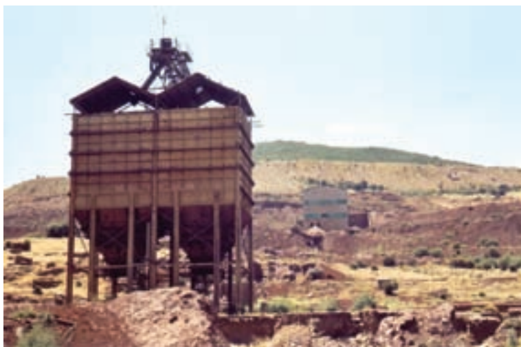
3. Sierra Menera. Tolvas de carga y nave de cribado al fondo. (Foto: LORENZO VALLES).
