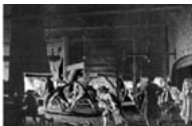
FIGURA 6. Pehr Hilleström: Forja de anclas de Söderfors, 1782.
