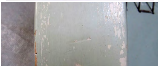
Fig 101 vista de la primera capa de pintura
