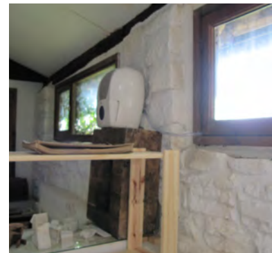
Fig 50 Instalación de deshumidificadores con sistema de drenaje continuado
