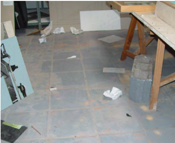
Fig 30 Detalle del suelo
