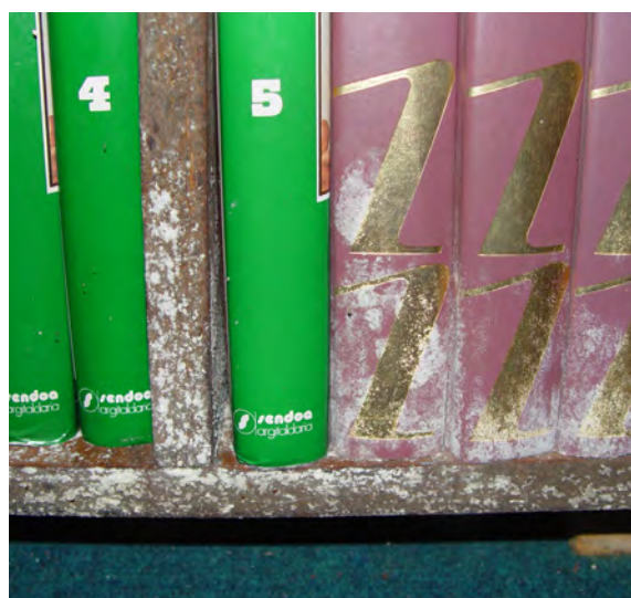
Fig 5 Vista en detalle de la presencia de hongos.
