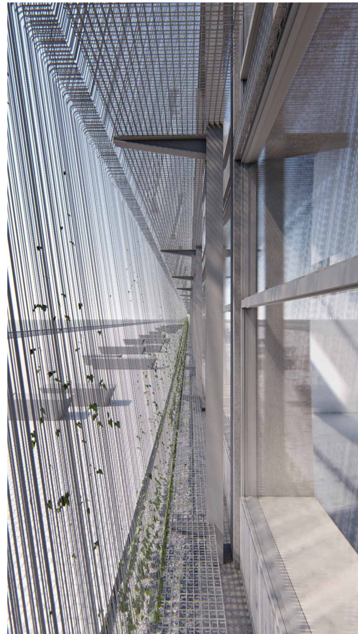
VISTA INTERIOR DE LA CELOSÍA PARA MANTENIMIENTO Y LIMPIEZA
