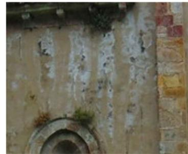
SOLUCION: Siendo el origen de dichas manchas la presencia de agua, se procurará eliminar tanto los defectos de la cubierta como la humedad por capilaridad de de las columnas y muros.
