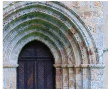
SOLUCION: Los elementos que no muestran un grado de erosión alto que distorsione la obra o que pueda significar un problema estructural, por lo que no es necesario ningún tipo de intervención.
