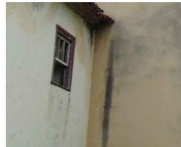
1. Un diseño incorrecto de los elementos de evacuación de aguas. En concreto la evacuación directa de agua sobre otros elementos en vez de una canalización hasta el exterior.
