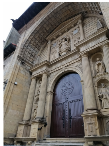
[Fig. 2: Detalle del pórtico]
