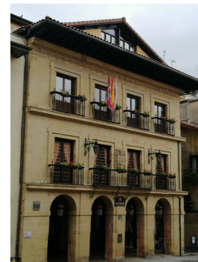
[Fig. 1: Fachada principal]
