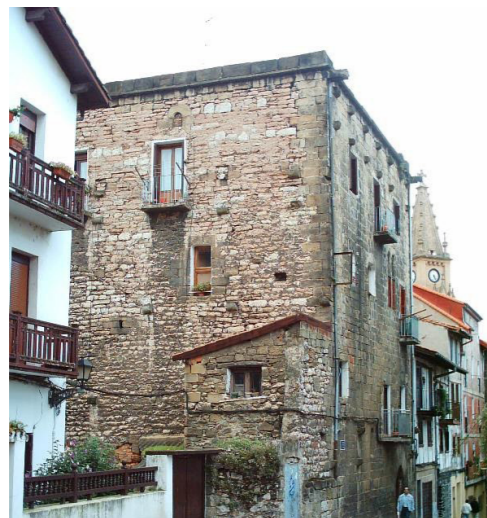
[Fig. 1: Torre Morrortxo desde la calle Miguel Alducin]
