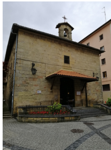
[Fig. 1: Exterior de la ermita]
