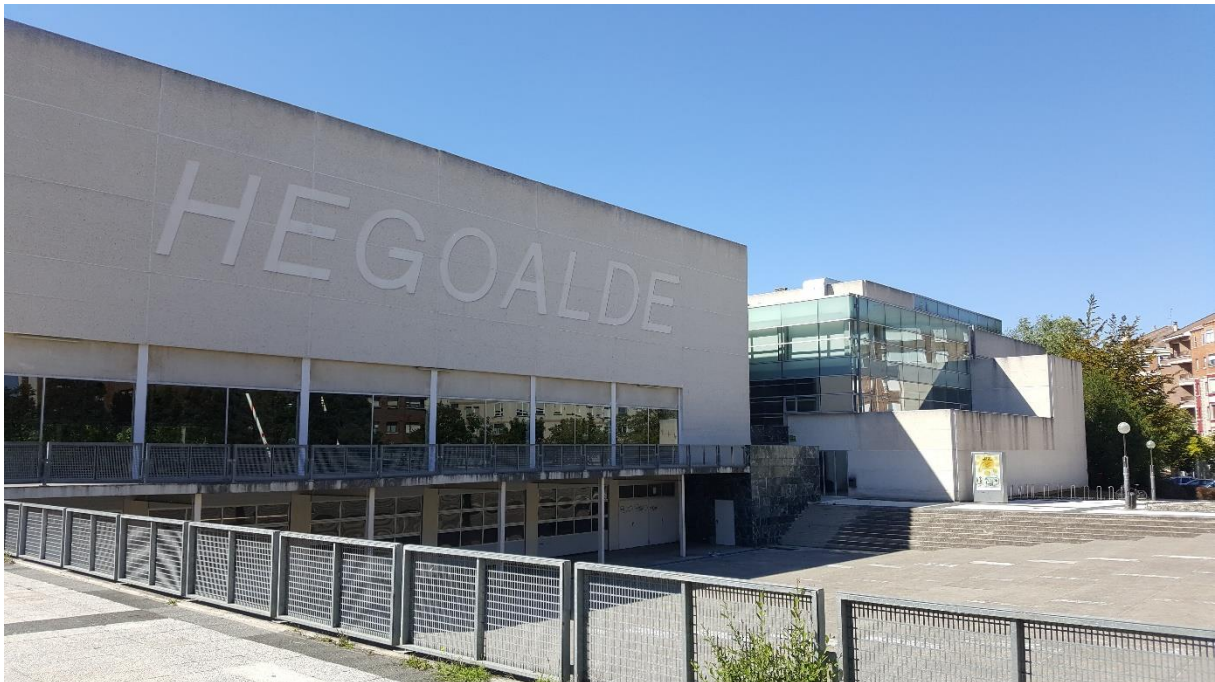
17. Ilustración. Cara este del edificio
