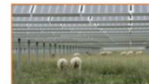
Granja solar de generación
