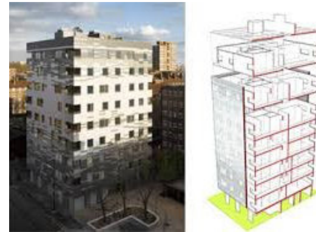
Imagen del video de youtube Top 5: The world Tallest Timber Buildings/ The BIM
